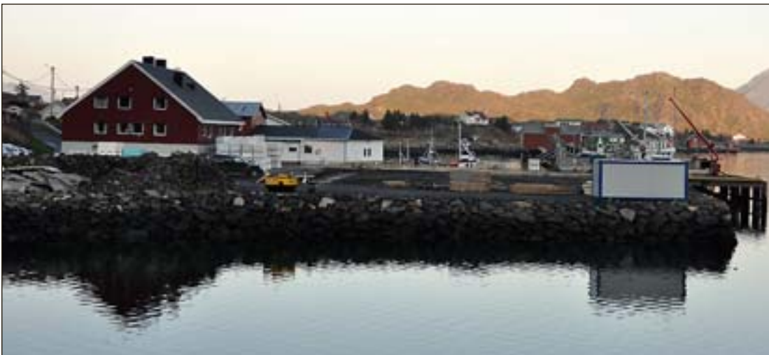
Nic. Haug AS på Ballstad bygger ut nytt mottaksanlegg for hvitfisk og pelagisk. Det er på fyllingen i forkant mottakshallen skal bygges. Foto: Kai Nikolaisen
