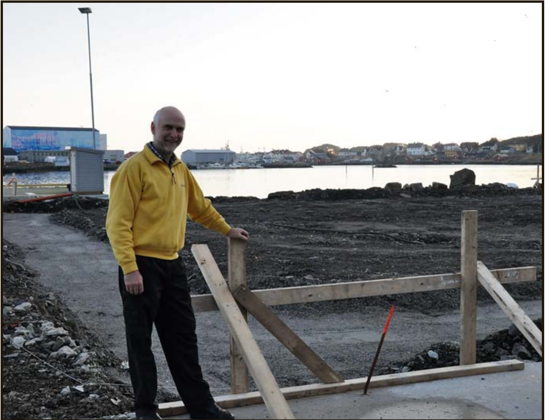
Helge Haug gleder seg til å ta i bruk den nye mottakshallen som skal stå ferdig 1. februar 2011.
